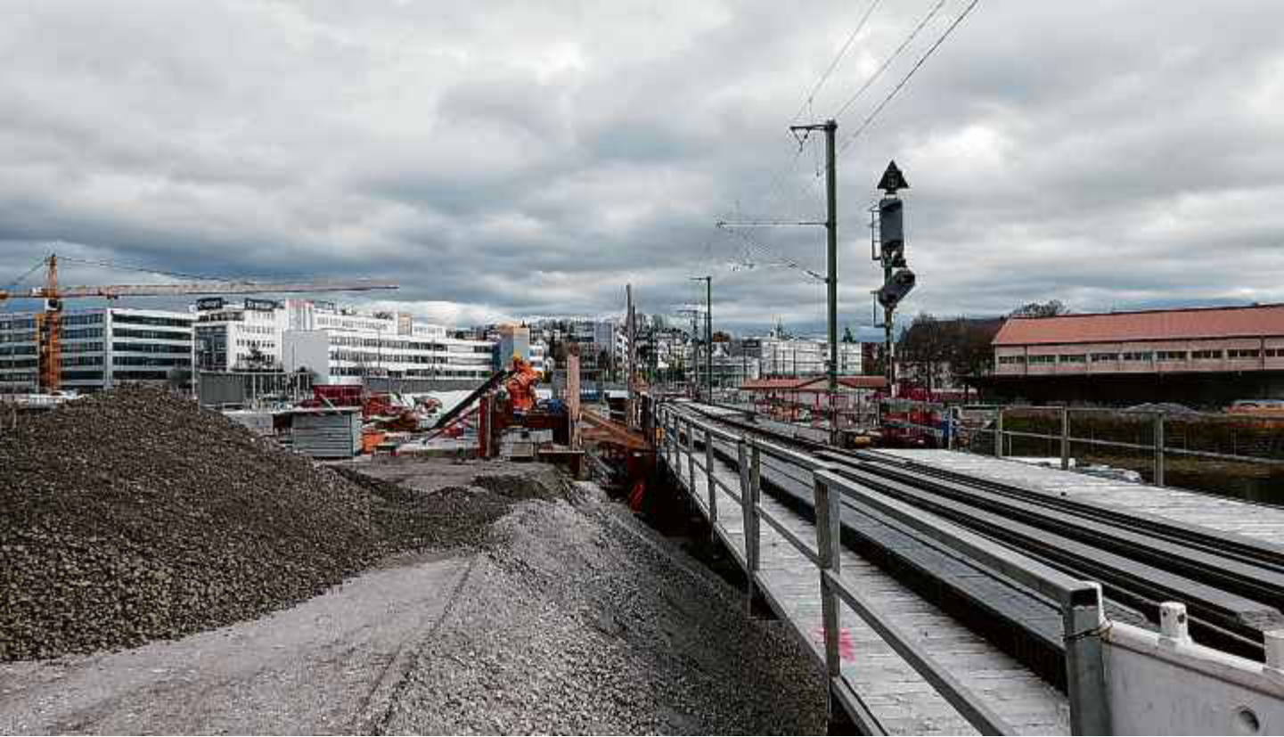
Die neue Brücke der Rankbachbahn über die Autobahn soll im April in Betrieb genommen werden.
